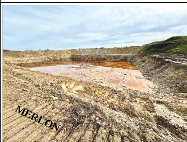
Photographie 3. Bassin créé côté Sud-Est – récupération des eaux de l'ancienne plateforme et des eaux de la zone de stockage Est
