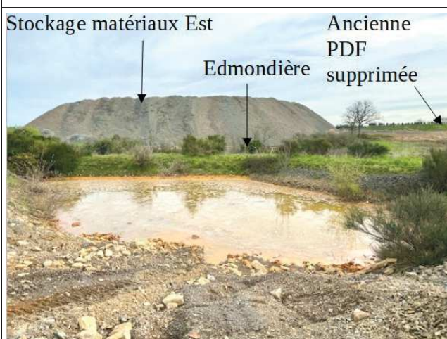
Photographie 5. Bassin n°1 de récupération des eaux pluviales de la zone de stockage Ouest
