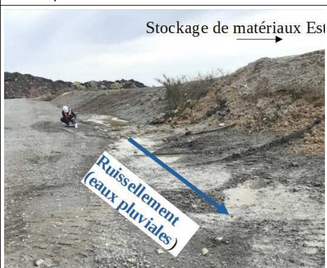
Photographie 4. Vue le long de la piste vers l'Est – gestion des eaux de ruissellement à réaliser
