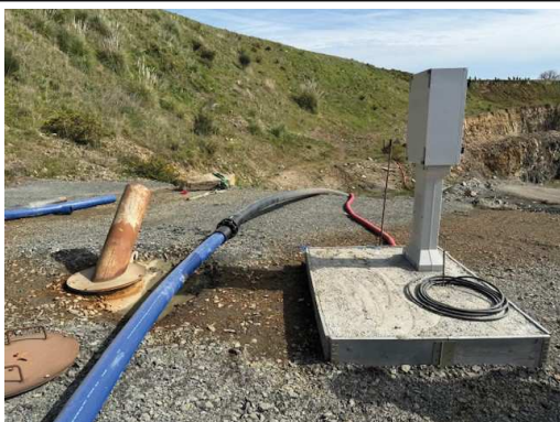
Photographie 17. Arrêt du rejet de la fosse Est – mise en place de tuyau
