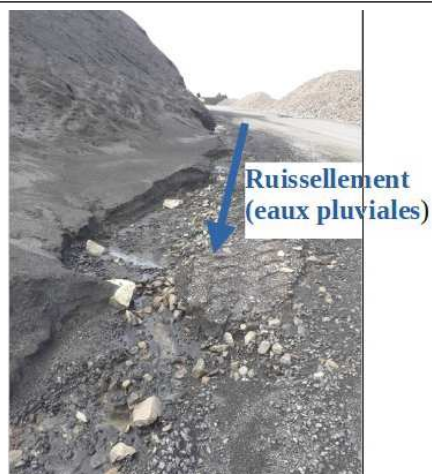
Photographie 8. Vue le long de la piste vers l'Ouest – gestion des eaux de ruissellement à réaliser
